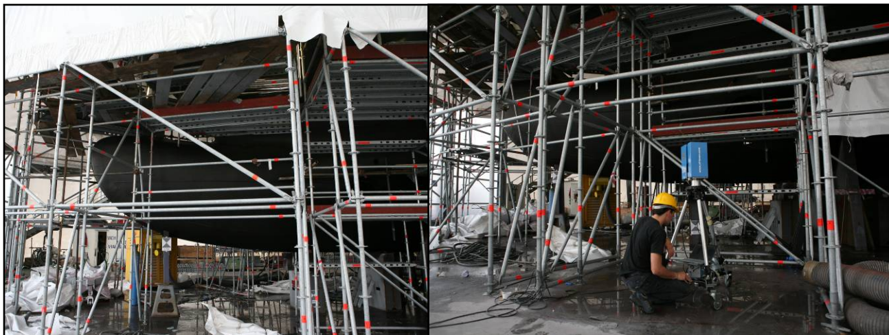
Figura 1 – Condizioni operative in cui è stato eseguito il rilievo
